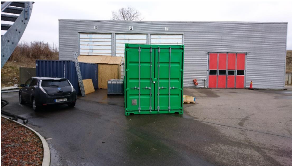
Figur 2. Testsite hos Biond i Helsingborg. Skruvpress och tork var placerade i lastbilsgaraget i fonden. I den gröna containern finns en mobil anläggning för fosforutvinning med Ekobalans process eco:P. eco:N-piloten inhystes i den blå containern, förutom stripperkolonnen som var placerad i lastbilsgaraget.
